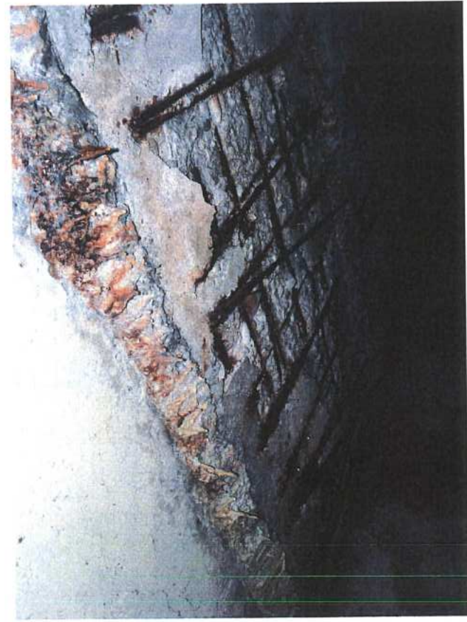
Výluhy mezi prefabrikáty, obnažená výztuž
