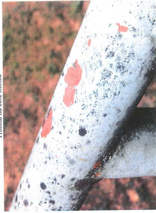
Koroze zábradlí
