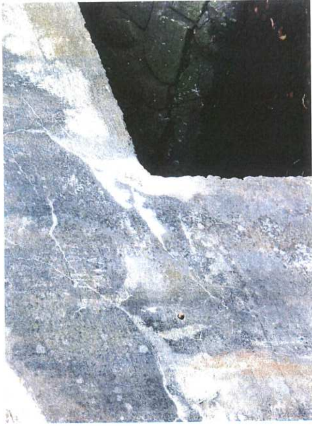
Trhlina na čele mostu
